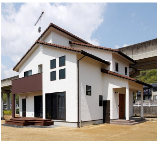
300坪ほどの広い敷地に建つS様邸。日当たりはいいし、風がよく通るので快適とのこと。バックに見えるのは井原鉄道の高架橋
