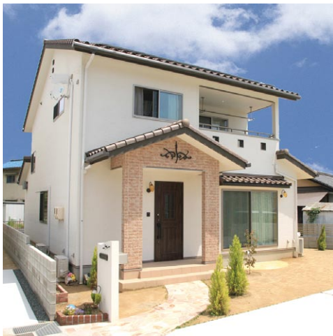
O様邸は、太陽光発電と家庭内エネルギー管理システム(HEMS・へムス)を組み合わせた家で、「スマートハウス」と呼ばれています
