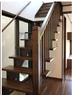
階段の下半分はオープンタイプで、採光・通風性を高めています
