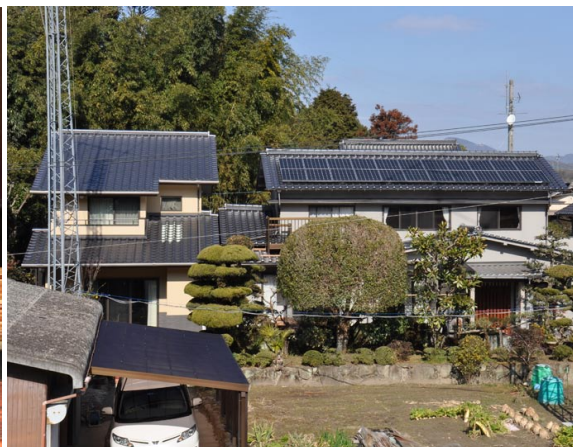
ソーラーパネルのある家がリフォーム工事をされた母屋。左側が新居になります。鉄塔には、アマチュア無線の大きなアンテナが取り付けられています
